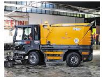
Das Technische Betriebszentrum (TBZ) schickte bereits Anfang der Woche ein Fahrzeug, das den Boden der Werkhalle einmal von Grund auf reinigte. Erst danach konnte das Technik-Team mit dem Aufbau beginnen. TRENKA
